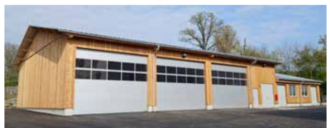
Die neu errichtete Maschinenhalle mit Praxis- und Lagerräumen.
